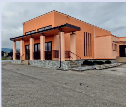
Rekonštrukcia domu smútku
