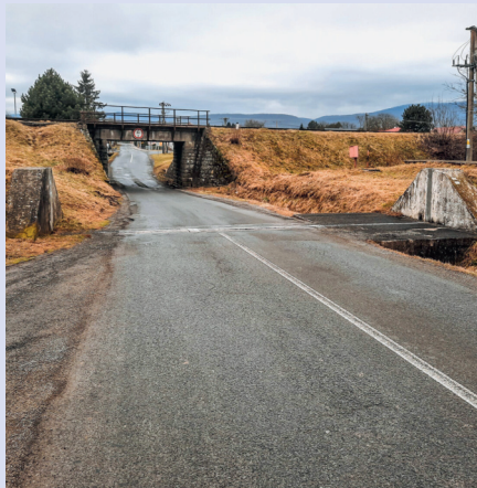
Protipovodňová ochrana obce - pred realizáciou
